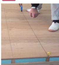
フローリングのジョイント部(根太上)を基準として一尺間隔でぽからシートの割付けを墨出します。
