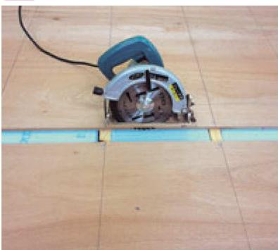
③の部分を丸ノコを使い80mm程度の配線経路を作ります。（コントローラ位置の壁までの追線経路も20mm程度で作ります）
