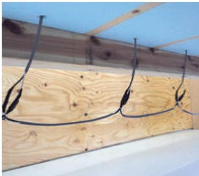
ぽからシート全てと追線が確実に接続されているかを確認します。
