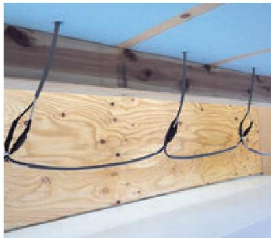
ぽからシート全てと追線が確実に接続されているかを確認します。
