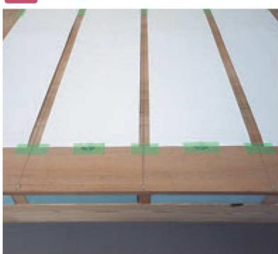
全てのリード線を投下し、開口部との不陸が無いように調整して、養生テープで仮止めします。1m間隔位で止めます。
