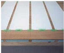
全てのリード線を投下し、開口部との不陸が無いように調整して、養生テープで仮止めします。更にシート全体がズレないように1m程度の間隔で止めます。
