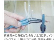
結線部分に湿気が入らないようにジョイントボックスおよび壁内での結線・圧着を推奨します。A5タイプのリード線は5mですが、長さが足りない場合は10mまたは15mタイプをお選びください。尚、結線部分には自己融着（フチル）絶縁テープを必ず巻き付けてください。
