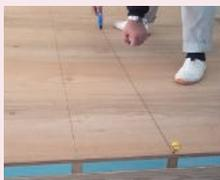
フローリングのジョイント部（根太上）を基準として一尺間隔でぼからシートの割付けを墨出しします。
