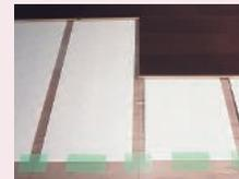
フローリングを仕上げる際はぼからシート間に接着剤をビード付けし、手打ちで釘を止めてください。
