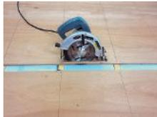
左ページ3の部分を丸ノコを使い80mm程度の配線経路を作ります。（コントローラ位置の壁までの追線経路も20mm程度で作ります）
