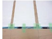
接続した追線を配線経路のぼからシートの下に凸部とならないように収め、養生テープで仮止めします。更にシート全体がズレないように1m程度の間隔で止めます。
