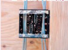
コントローラ取付け位置（目安：床から1200mm程度）を決め、壁にJISスイッチボックス2個用深型（現場調達）を取付け、一次側電源コード（二次側負荷コード）を配線します。
