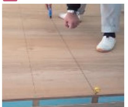
フローリングのジョイント部(根太上)を基準として一尺間隔でぽからシートの割付けを墨出します。
