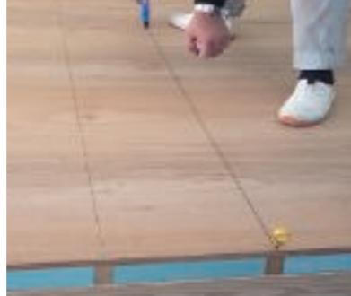
フローリングのジョイント部(根太上)を基準として一尺間隔でぽからシートの割付けを墨出します。
