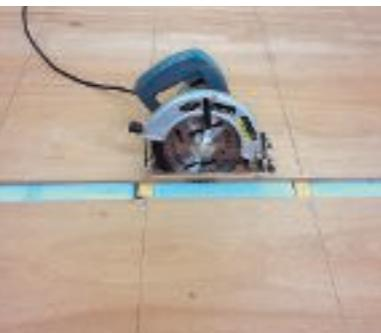
③の部分を丸ノコを使い80mm程度の配線経路を作ります。(コントローラ位置の壁までの追線経路も20mm程度で作ります)
