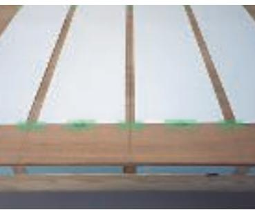
断熱材は硬質発泡45mm以上を推奨します。
