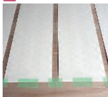
全てのリード線を投下し、開口部との不陸が無いように調整して、養生テープで仮止めします。更にシート全体がズレないように1m程度の間隔で止めます。
