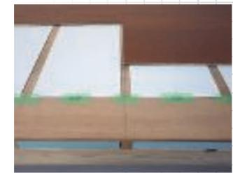
無垢小幅フローリングを使用する際は、ぽからシート上に合板5.5mmを張ってから施工してください。
