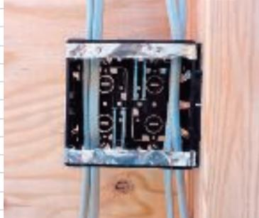
コントローラ取付け位置 (目安: 床から1200mm程度) を決め、壁にJISスイッチボックス2個用深型 (現場調達) を取付け、一次側電源コード (二次側負荷コード) を配線します。
