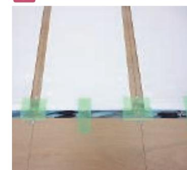
接続した追線を配線経路のぽからシートの下に凸部とならないように収め、養生テープで仮止めします。更にシート全体がズレないように1m程度の間隔で止めます。
