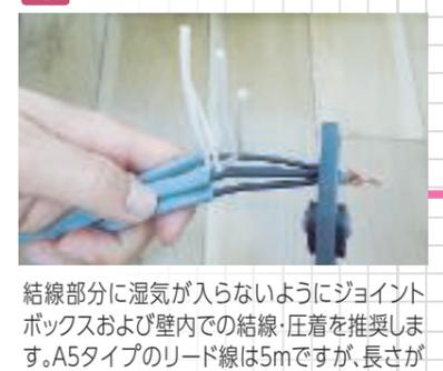
結線部分に湿気が入らないようにジョイントボックスおよび壁内での結線・圧着を推奨します。A5タイプのリード線は5mですが、長さが足りない場合は10mまたは15mタイプをお選びください。尚、結線部分には**自己融着 (ブチル) 絶縁テープ**を必ず巻き付けてください。
