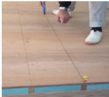
フローリングのジョイント部 (根太上) を基準として一尺間隔でぽからシートの割付けを墨出しします。
