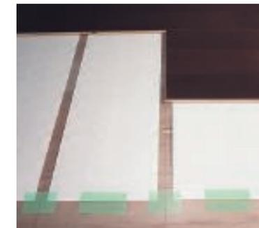
フローリングを仕上げる際はぽからシート間に接着剤をビード付けし、手打ちで釘を止めてください。
