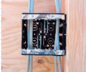
コントローラ取付け位置 (目安: 床から1200mm程度) を決め、壁にJISスイッチボックス2個用深型 (現場調達) を取付け、一次側電源コード (二次側負荷コード) を配線します。
