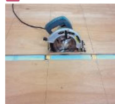
3の部分丸ノコを使い80mm程度の配線経路を作ります。 (コントローラ位置の壁までの追線経路も20mm程度で作ります)
