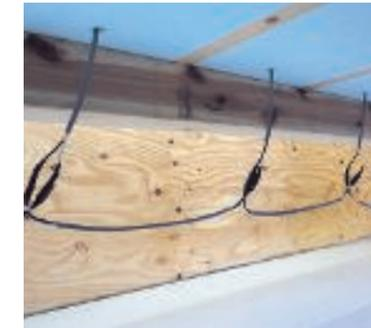
ぽからシート全と追線が確実に接続されているかを確認します。追線が地面につかないようにしてください。
