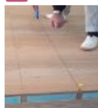
フローリングのジョイント部 (根太上) を基準として一尺間隔でぽからシートの割付けを墨出しします。
