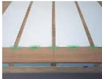
断熱材は硬質発泡45mm以上を推奨します。
