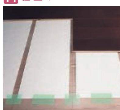
フローリングを仕上げる際はぽからシート間に接着剤をビード付けし、手打ちで釘を止めてください。
