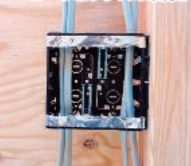
コントローラ取付け位置(目安:床から1200mm程度)を決め、壁にJISスイッチボックス2個用深型(現場調達)を取り付け、一次側電源コード(二次側負荷コード)を配線します。
