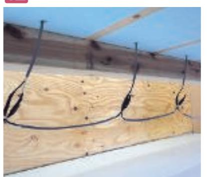
ぽからシート全てと追線が確実に接続されているかを確認します。追線が地面につかないようにしてください。
