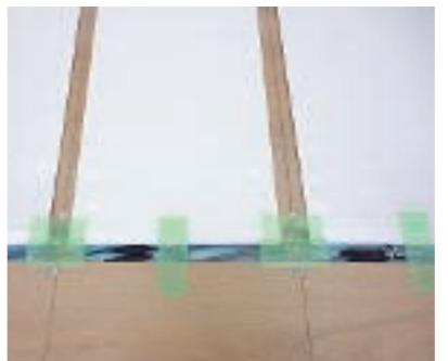
接続した追線を配線経路のぽからシートの下に凸部とならないように収め、養生テープで仮止めします。更にシート全体がズレないように1m程度の間隔で止めます。
